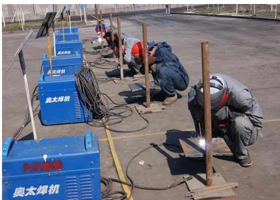
焊工鉴定考试现场操作
